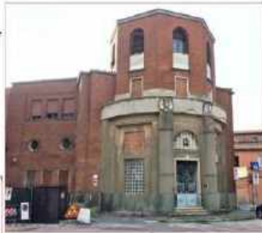
Ex Casa del Mutilato (muratura in laterizio a vista, rivestimento in pietra, cornicione intonacato)
