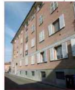
Edificio residenziale lato est mercato (muratura in laterizio a vista, risalti intonacati e tinteggiati in grigio chiaro, zoccolatura rivestita in pietra grigia)
